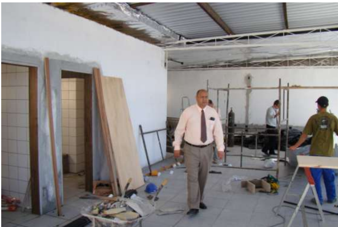
Colocando as aberturas.
