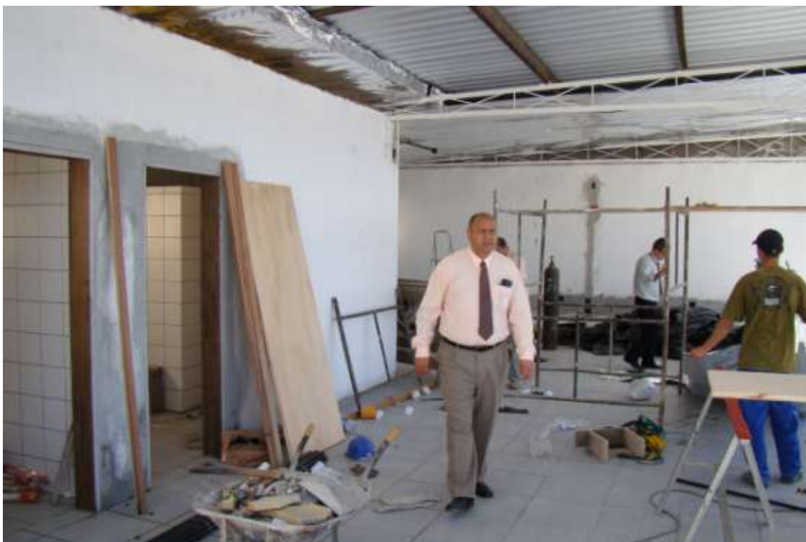
Colocando as aberturas.
